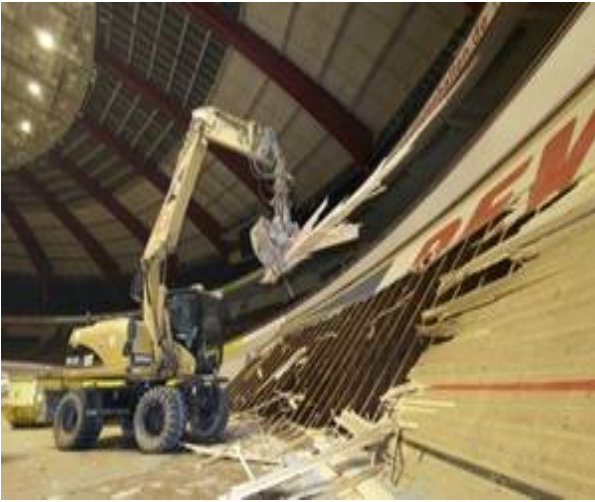
Foto: Szenen vom heutigen Abbau der Radrennbahn in der Westfalenhalle 1.
